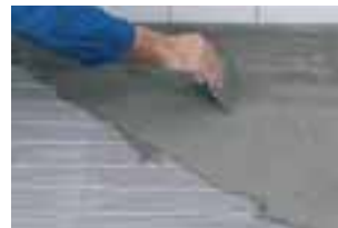
03 Netzheizmatte mit Flexkleber überstreichen.
