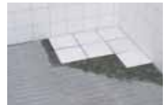
04 Zweite Lage mit Fliesen in gewohnter Weise verlegen.
