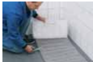
02 Netzheizmatte kann, falls es die Verlegegeometrie erfordert, umgelegt werden.
