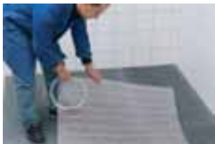
01 Netzheizmatte nach dem ETHERMA-Verlegeplan auslegen.
