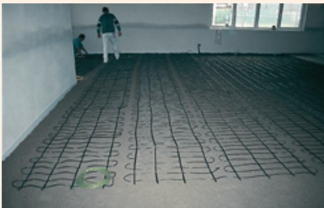
Einfach auslegen auf die roh abgezogene erste Estrichlage, dann den Estrich fertigstellen.
