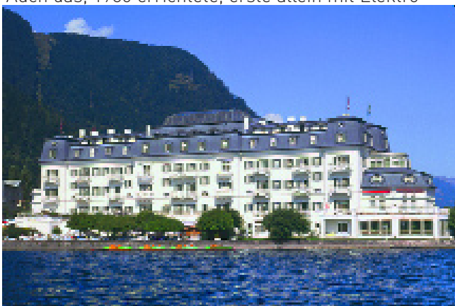
Fußbodenheizung beheizte Großhotel Europas.
